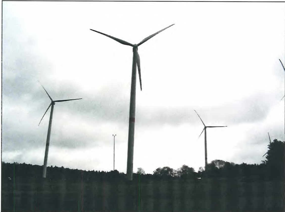
Abbildung 2 Ausblick auf einige der Windenergieanlagen im Windpark Waigandshain
