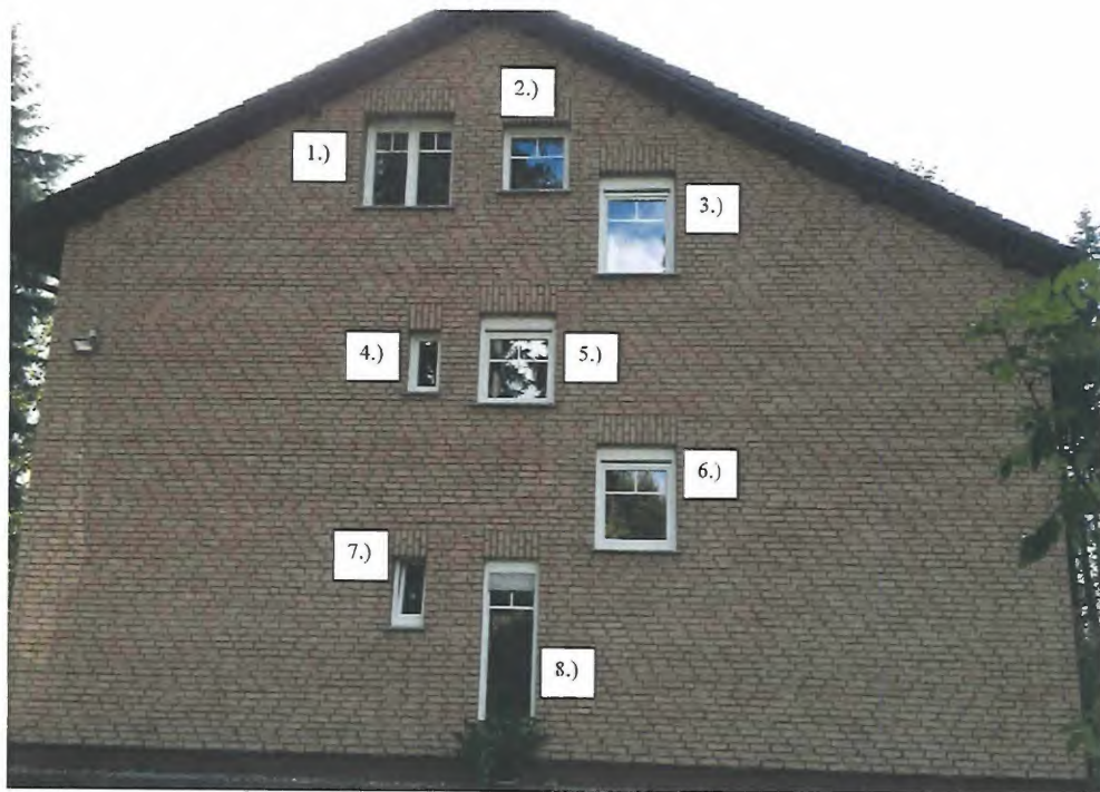
Bild 9: Immissionsort IO-06, Fassadenseite Nordost, mit Erläuterung der Räume
