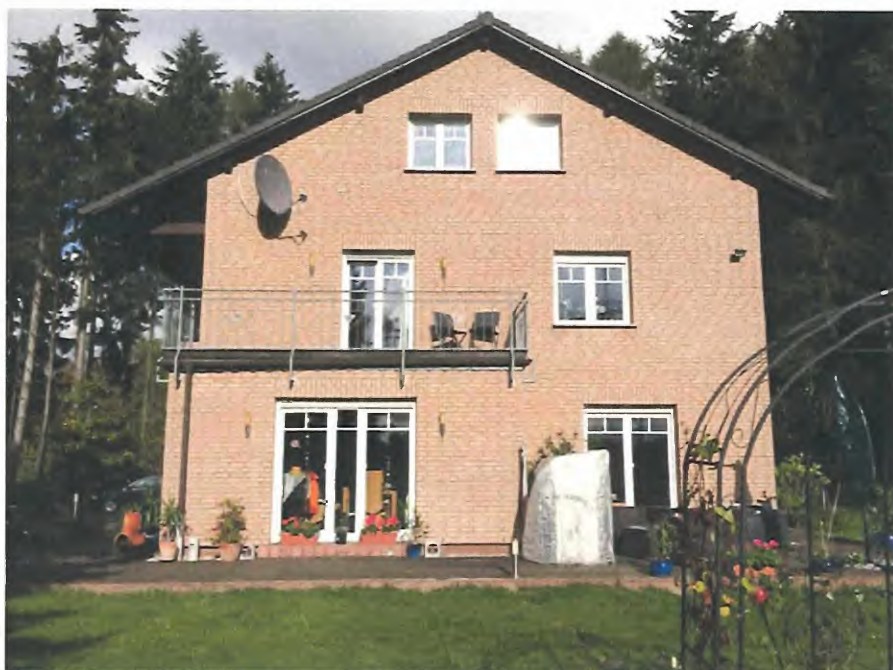
Bild 7: Immissionsort IO-06, Fassadenseite Süd
