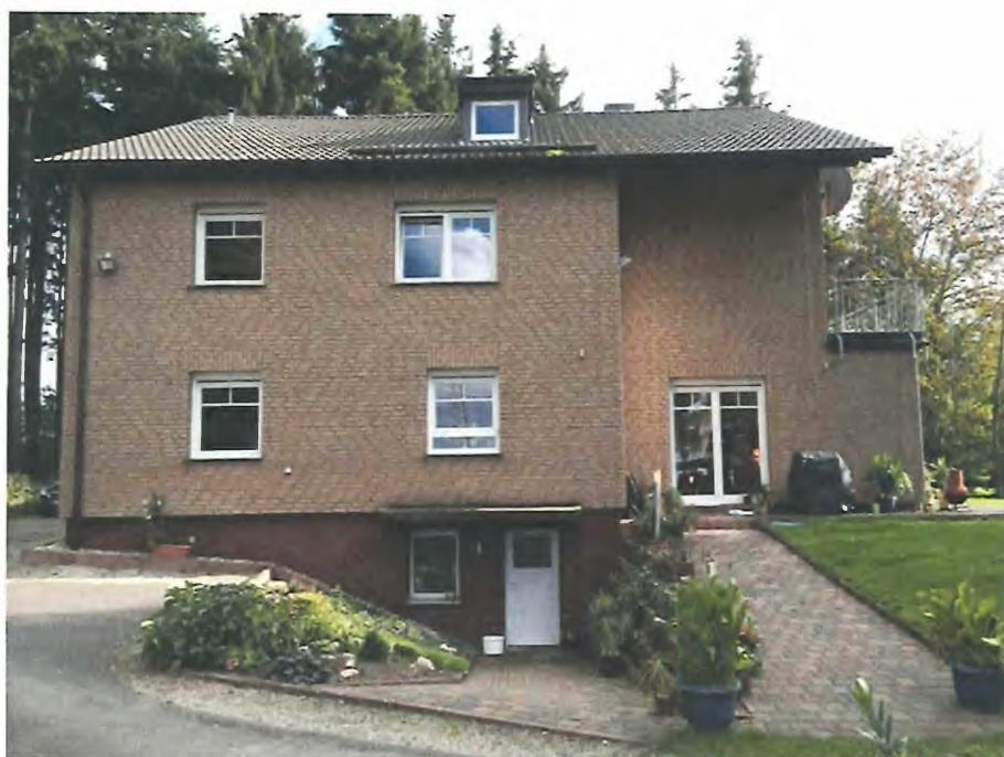
Bild 6: Immissionsort IO-06, Fassadenseite Nordwest
