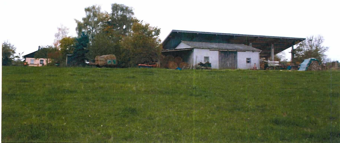
Abb. 8: IP B (Wohnhaus von der Scheune verdeckt)
