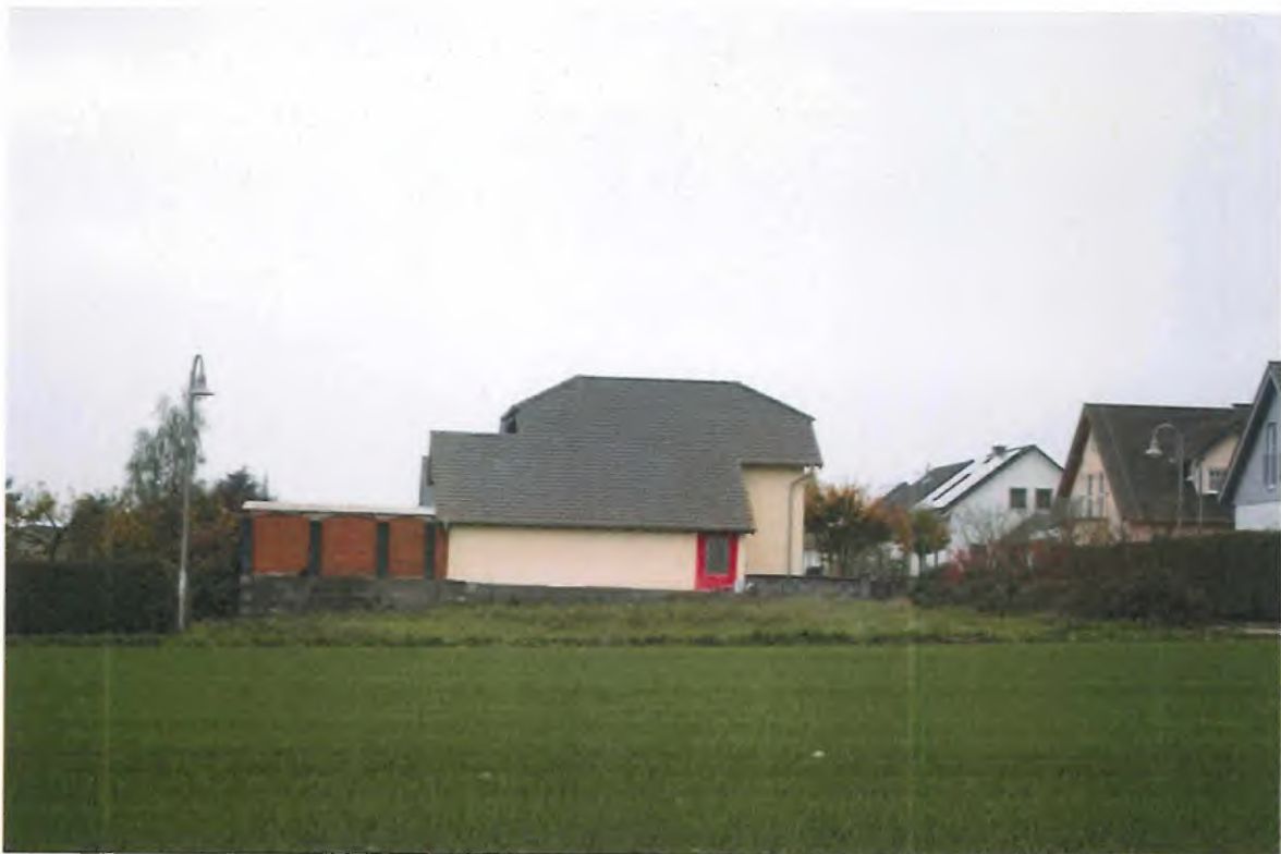
Abb. 38: IP BB (gemeint ist hier die Freifläche vor dem Haus – das Gebäude mit der roten Tür ist IP V)
