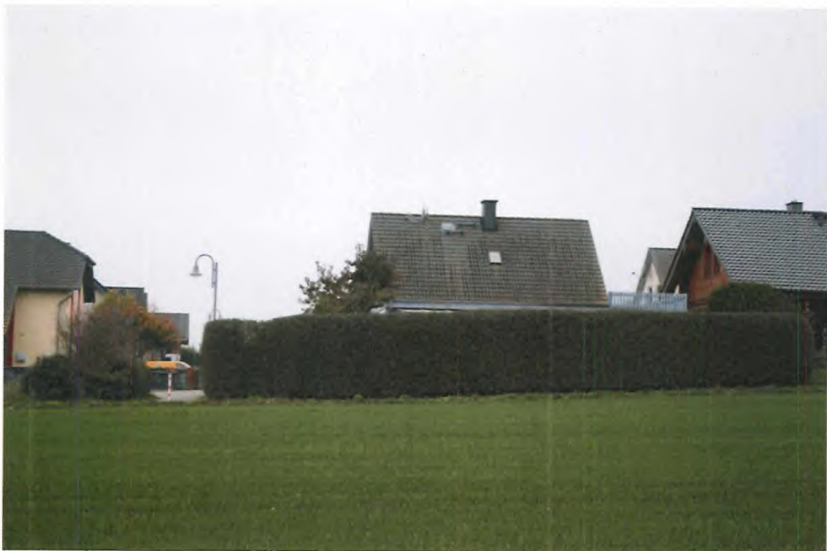
Abb. 34: IP AB (Wohnhaus hinter der Hecke))
