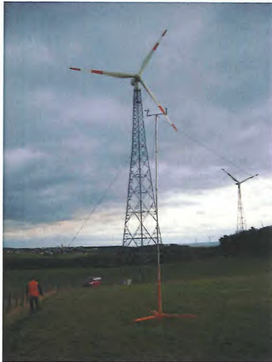
Abbildung A 4. Blick auf den Standort des Mastes und die WEA.
