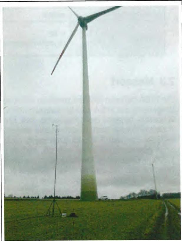
Abb. 3: Aufbau Windmessmast
